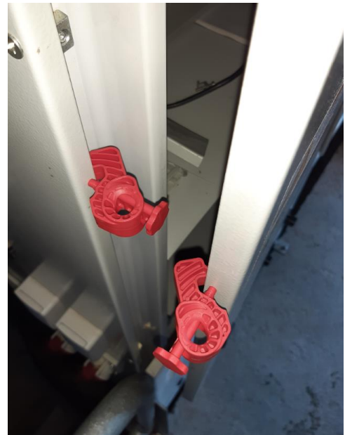
Instalación de los dos TBUD Both TBUD installed
